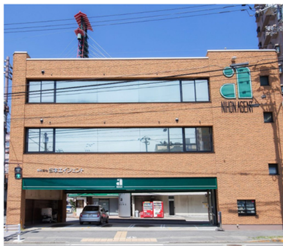
[日本エイジェント社屋]
